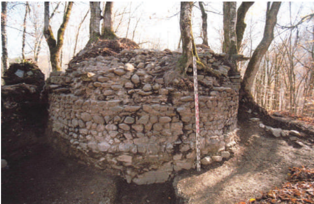
Рис. 2. Фотография западного фасада полукруглой башни. Вид с запада. Фото Д. Э. Василенко, 2007 г.
