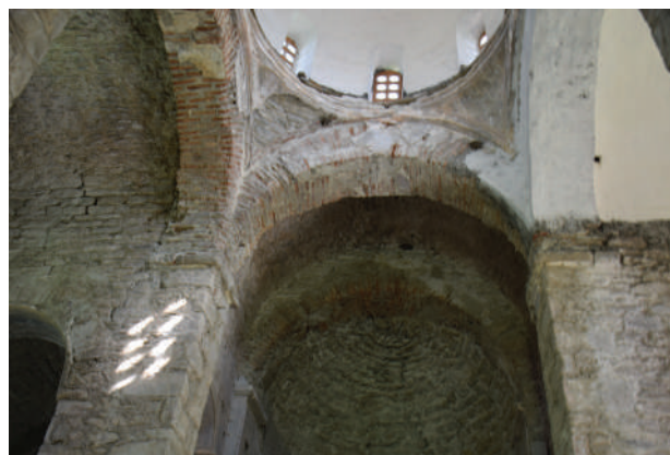
Рис. 10. Внутренняя часть храма с аркообразными сводами
