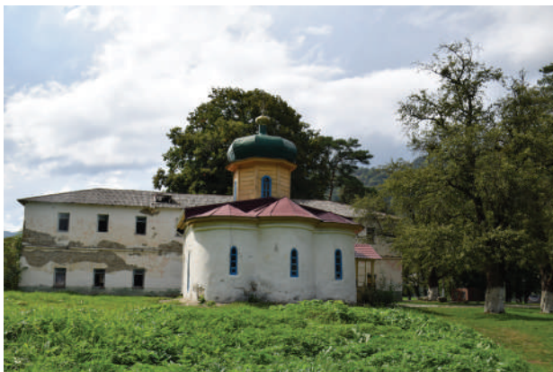
Рис. 12. Внешний вид Южного храма с восточной стороны
